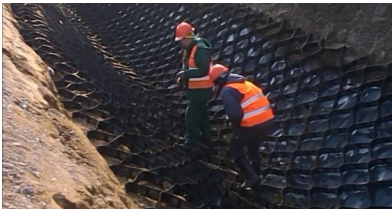
Fotografia 1. Umocnianie dna i skarp rowu materacami geokomórkowymi
