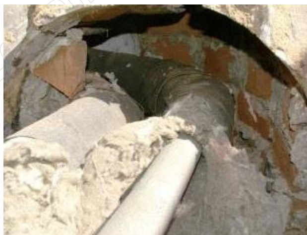
Rys. 2. Przyłącze ciepłownicze
