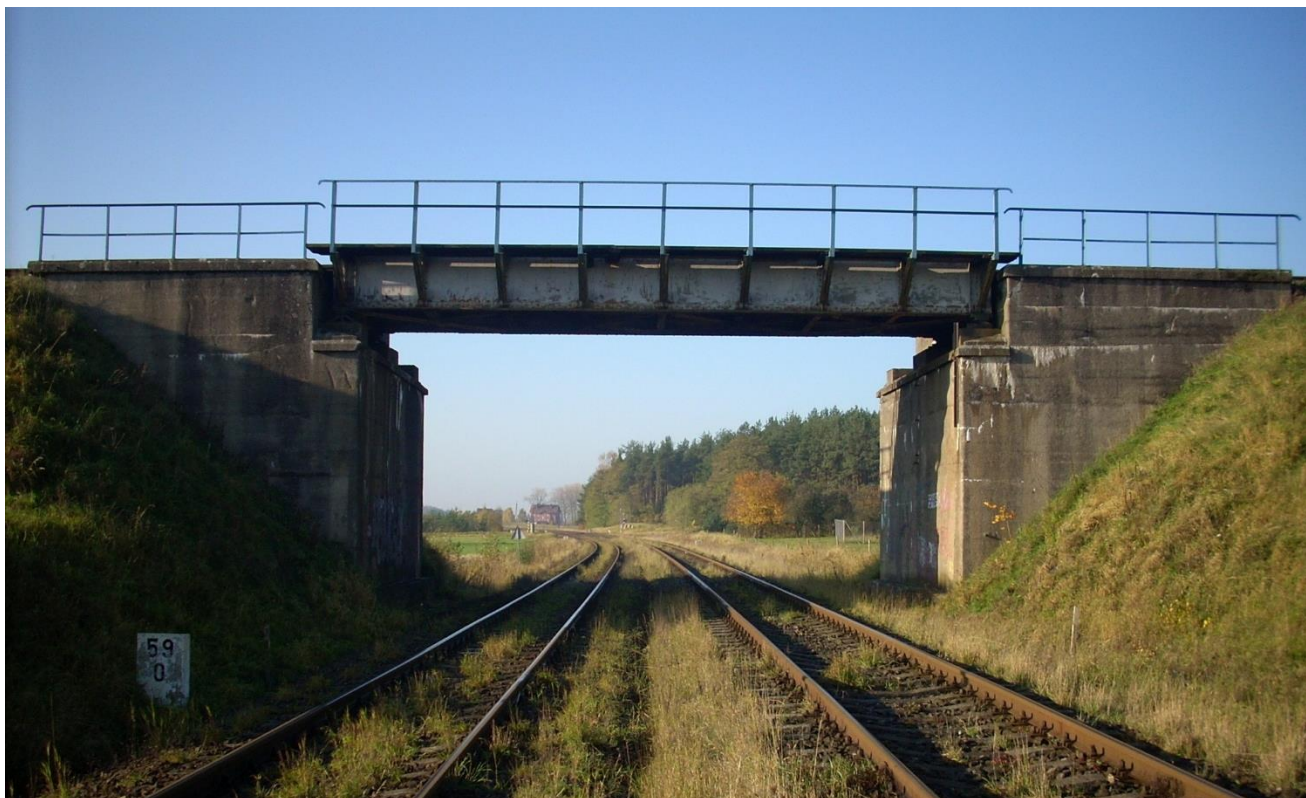
Ilustracja 1. Kolejowy obiekt inżynierski w km 104,000 linii kolejowej nr 201
