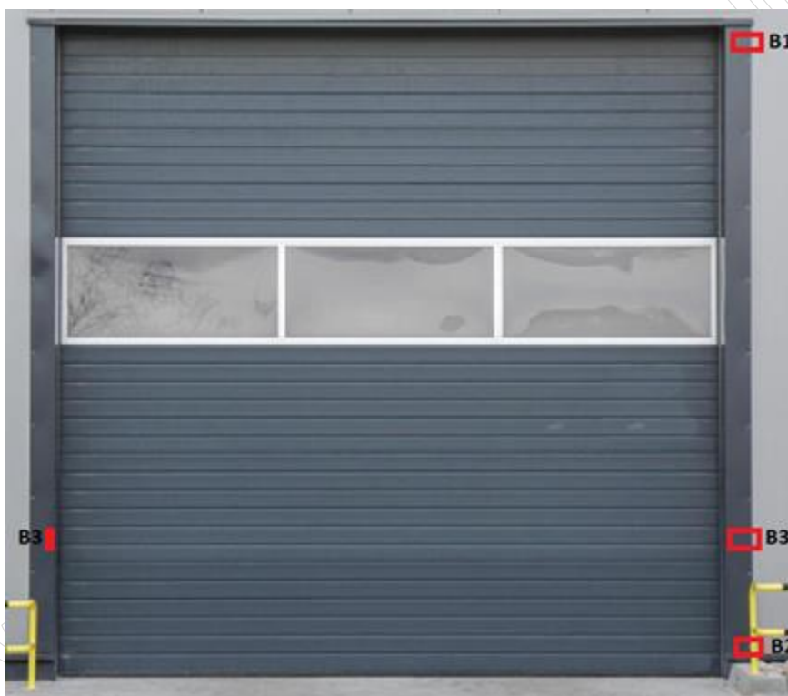
Rysunek 1. Brama przemysłowa z rozmieszczeniem czujników
